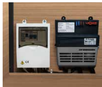
+ 12-Volt-Stromversorgung und LED-Anzeige bei defekter Sicherung
