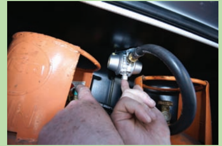
Preverijo delovanje varnostnega ventila Secumotion.
