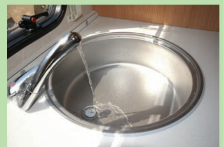
Sledi pregled delovanja vodovodne napeljave, vodne črpalke ter pip.
