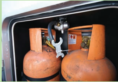
V prostoru za jeklenke priklopijo plinske jeklenke.
