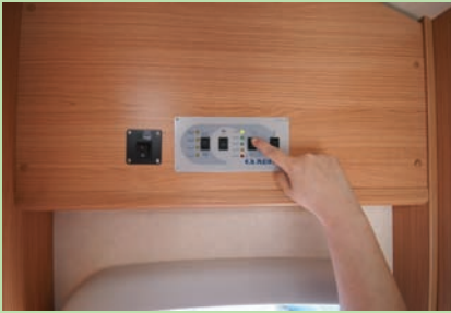
Na nadzorni plošči preverijo nivo sveže vode v rezervoarju.
