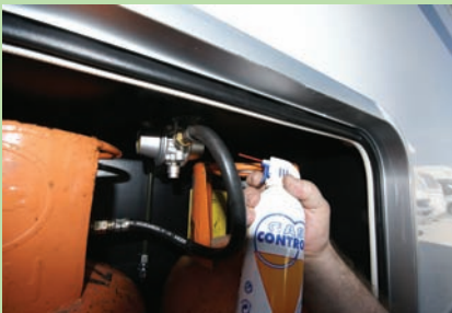
S posebnim sprayem preverijo tesnjenje plinske napeljave.
